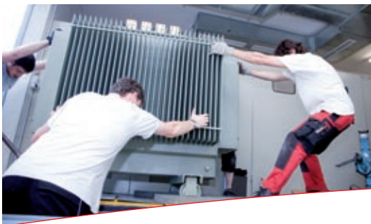
Beim Einbringen des Öltransformators in die Trafobox ist Zupacken gefragt.
