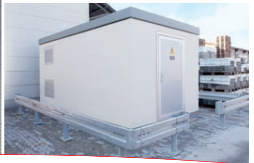
In einer Beton-Kompaktstation sind die Schaltanlagen und der Transformator sicher aufgehoben.
